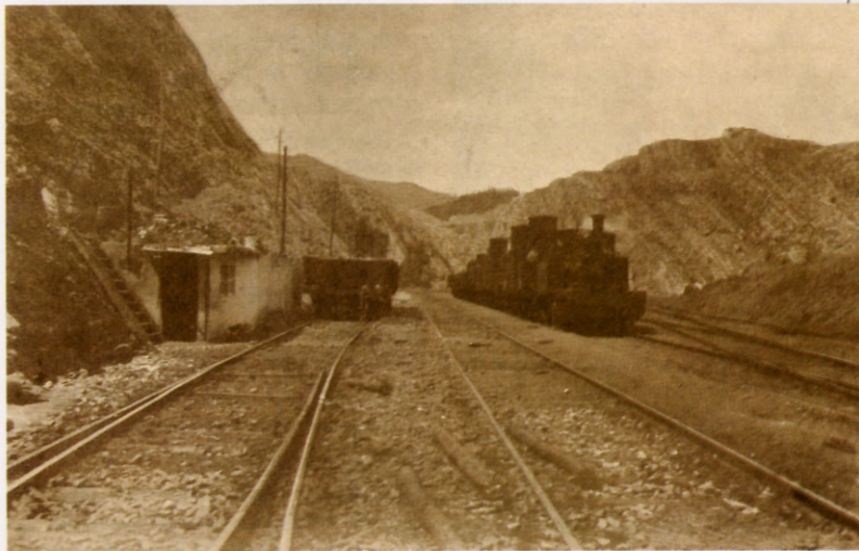
Perspectiva de las vías de entrada al Apartadero y salida para la báscula del material cargado al ferrocarril del Norte (fotografía de 1918).
